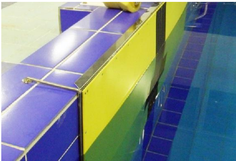
Панель БТ-405 (2,4 м), крепление в анкер.
